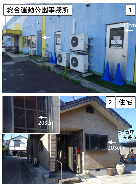
写真2 合津地区における建物の浸水被害
