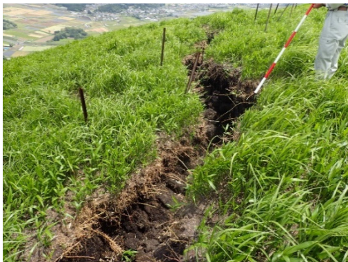
写真-1 熊本地震時に発生した亀裂
