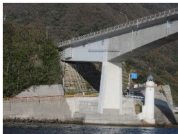
橋の室津側橋脚部
