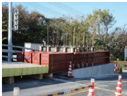
橋の室津側橋端に応急荷重
