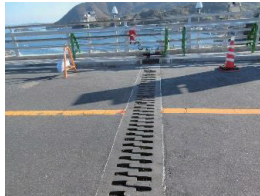
橋の中央ピン接合部
