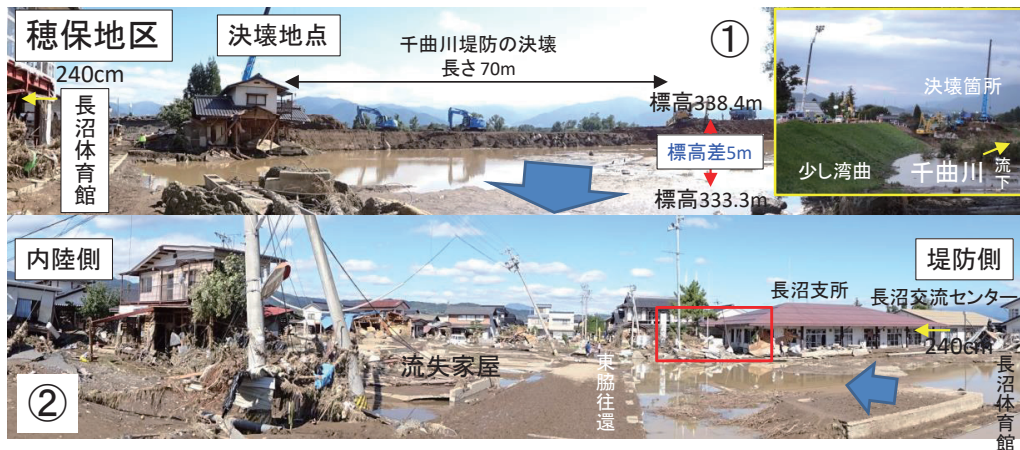
写真1 千曲川堤防の決壊と穂保地区における洪水被害の状況（2019年10月16日撮影）
