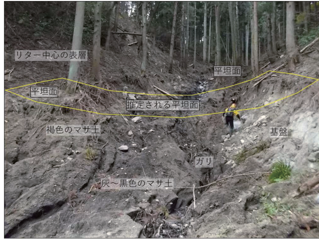
写真2 崩壊地Aの中間付近の状況
