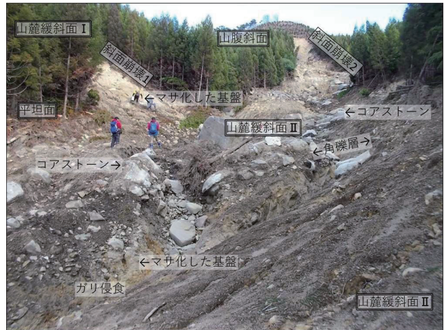
写真4 崩壊地Bの中間付近の状況
