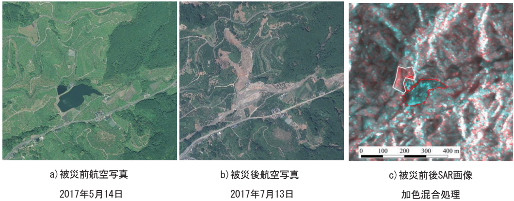
図4.1 山の神池斜面崩壊・ため池決壊の様子
