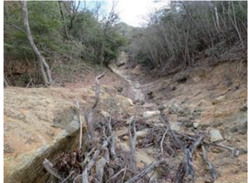
図8 源頭部方向の状況
