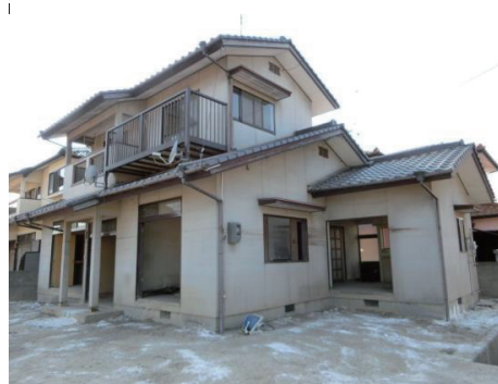
写真2 有井地区の住宅被害（2019.8.6）
