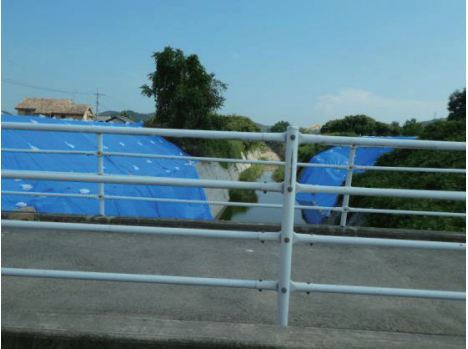
写真3 末政川の堤防仮補修（2018.8.6）
