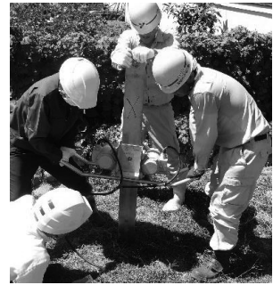
(a) 打ち込み工程
