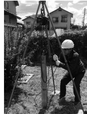
(b) 引き揚げ工程
