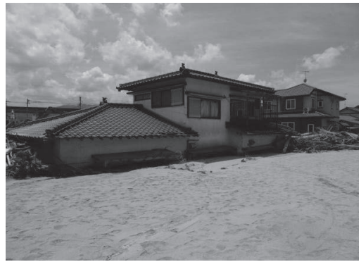
写真4 北川下流の杷木志波地区における真砂土の住宅地への堆積（2017年7月15日撮影）
