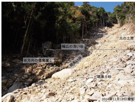
写真4 Loc. 4の斜面崩壊
